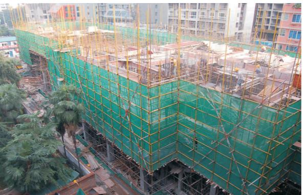
9月22日，新教学楼完成浇筑三层柱、四层梁、板。
